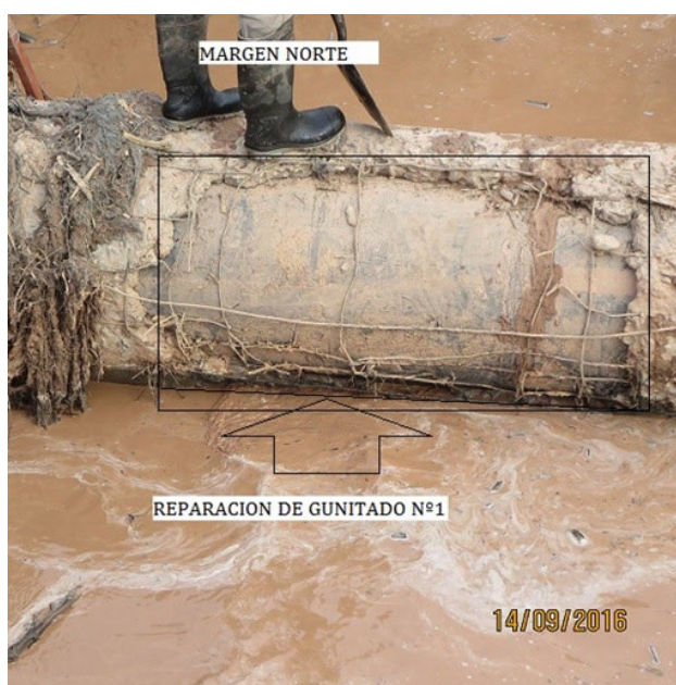
Figura 8. Daños en el contrapesado de hormigón por impacto de rocas por acarreo de fondo
