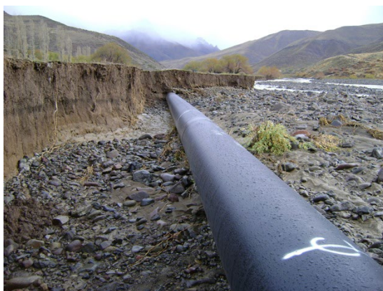
Figura 6. Erosión por acercamiento o invasión de pista en un ducto paralelo al río
