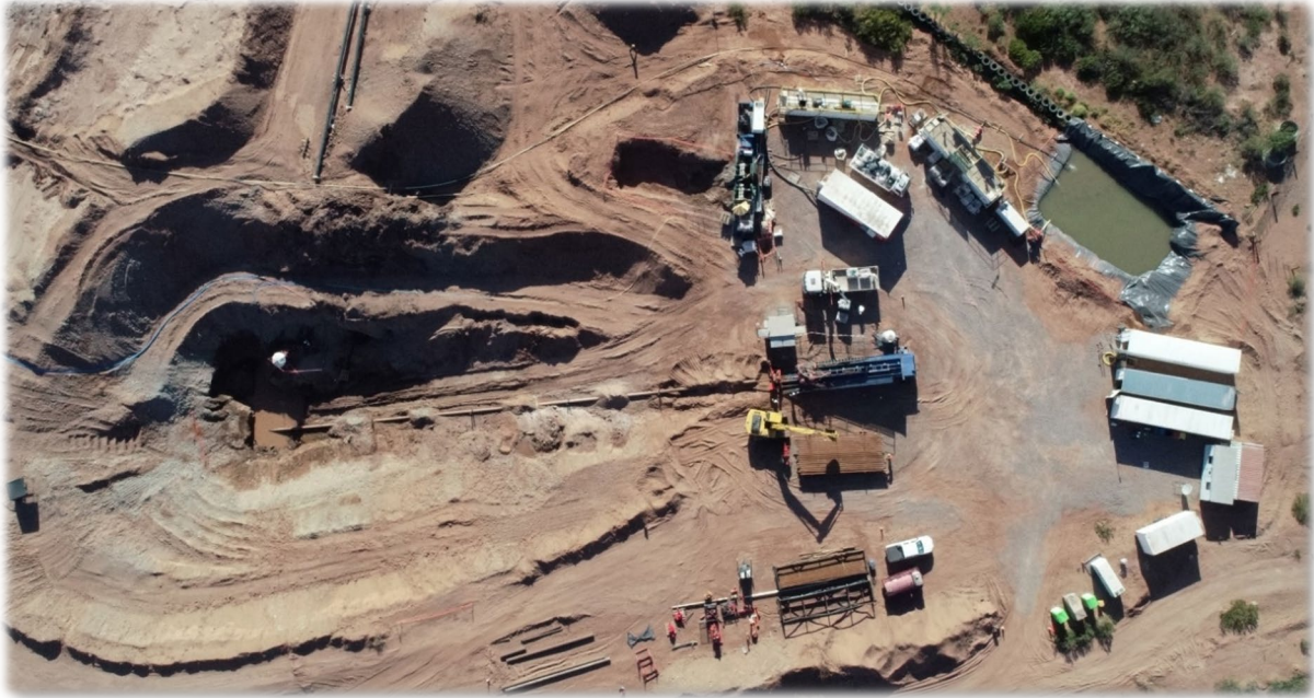
12. Locación de Rig Side
