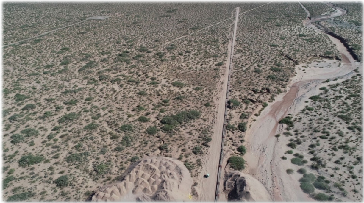
14. Desfile de cañería soldada y revestida
