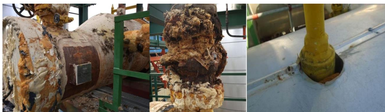
Figura 29: Zonas afectadas por CUI en intercambiador de calor II en zonas susceptibles a temperaturas críticas – Complejo
