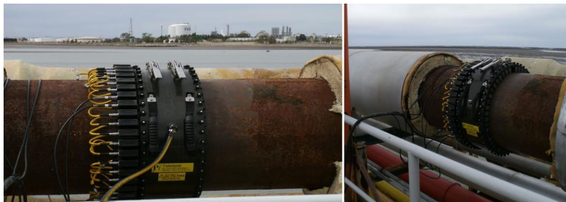
Figura 34: END de ondas guiadas en líneas de producto refrigerado – Puerto Galván
