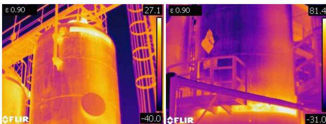
Figura 35: END de termografía en recipientes a presión aislados.
