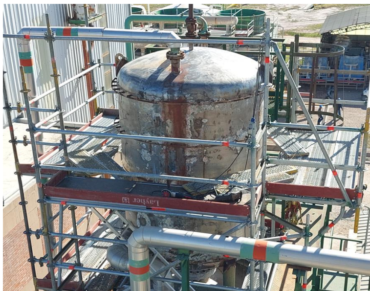
Figura 21: Torre desaeradora – Planta Ecoenergía
