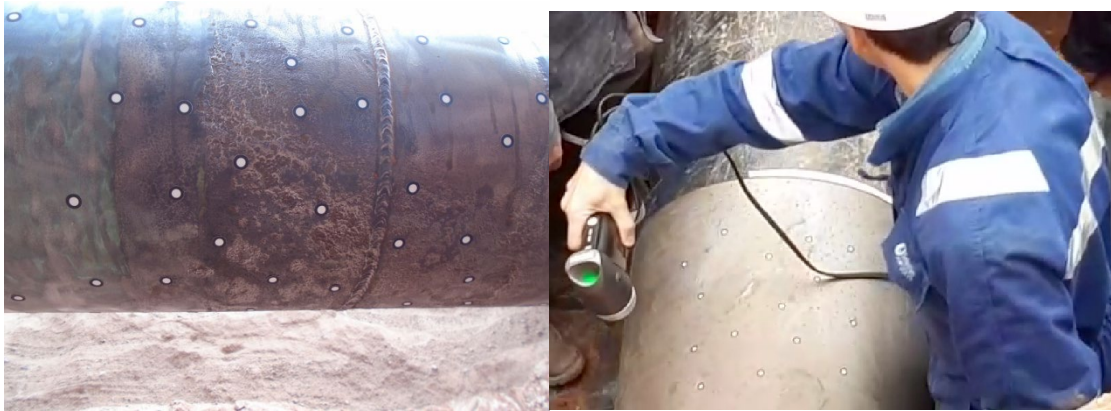
Figura 2. Preparación superficial y escaneo de área de interés
