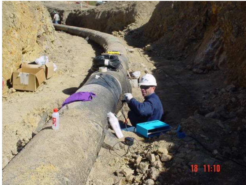
Figura 21. Soldadura de strain gauge
