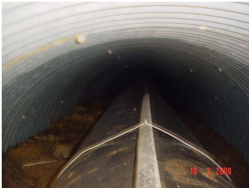
Figura 27. Inspección de la posición de la cañería luego del tapado de zanja
