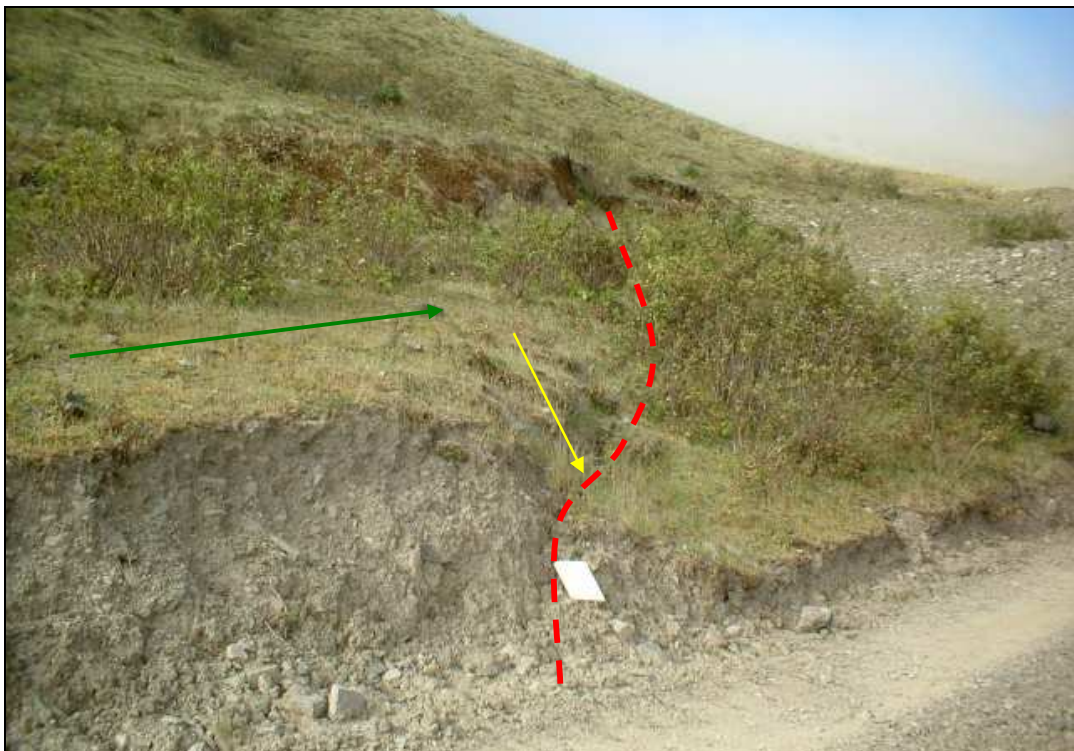
Figura 6. Flanco derecho del deslizamiento: grieta de tracción principal, con marcado desplazamiento vertical
