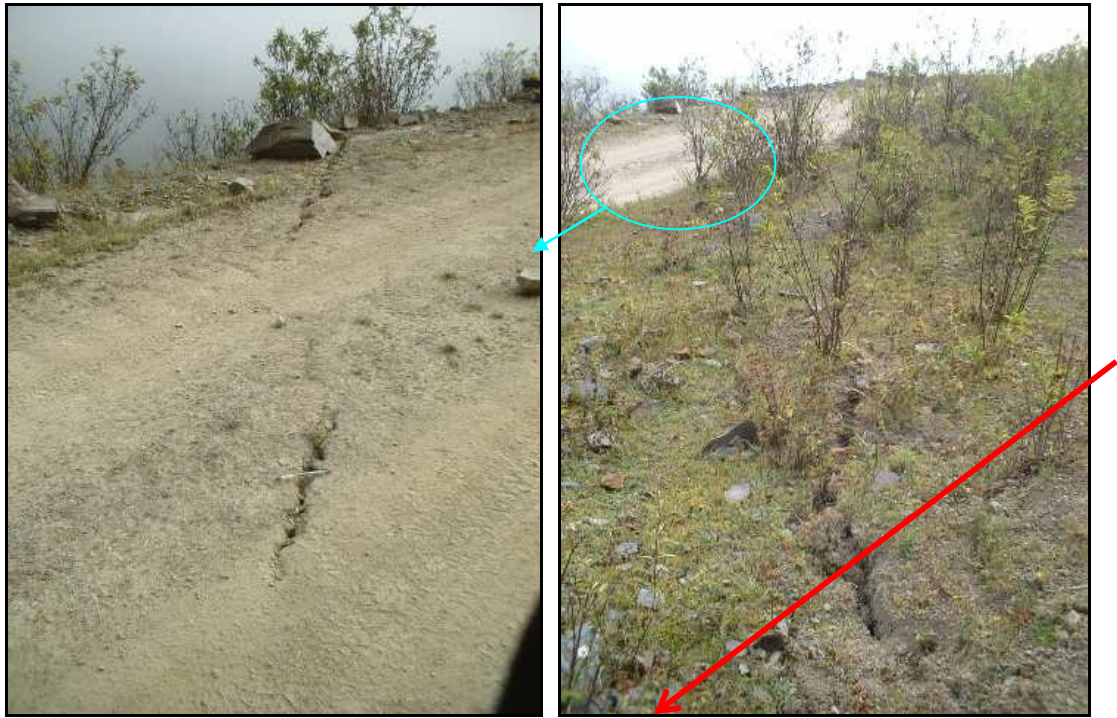
Figura 5. Flanco derecho (Este) del deslizamiento: grietas de tracción secundarias en el camino de asistencia y en la pista.
