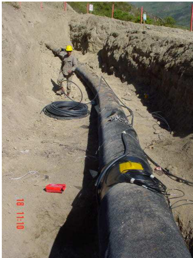
Figura 20. Strain Gauge instalado a hora 12
