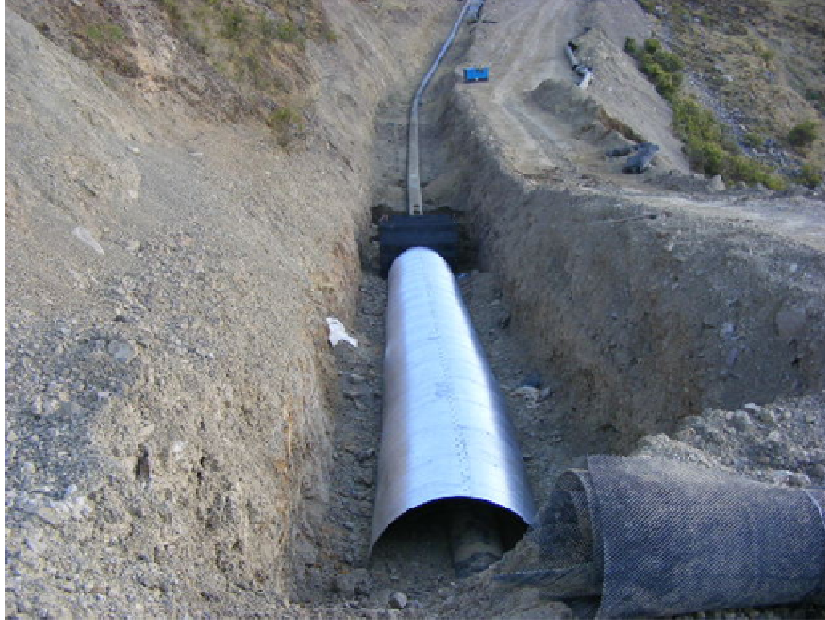
Figura 26. Colocación de caños de chapa corrugada sobre la cañería.
