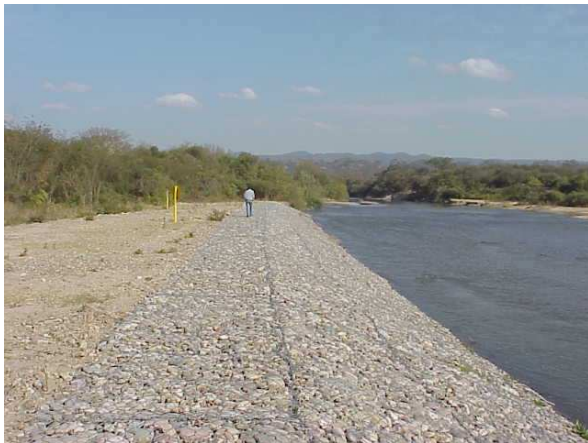
Figura 36: protección de margen con colchonetas
