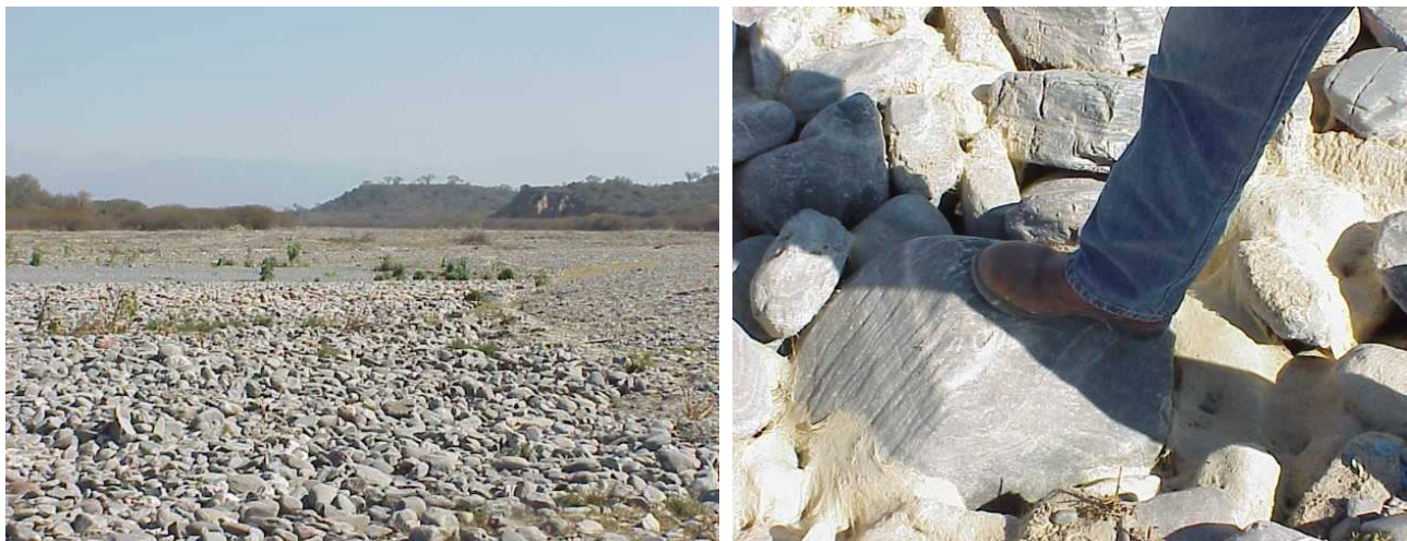
Figuras 17 y 18: ejemplos de revestimientos de rip-rap
