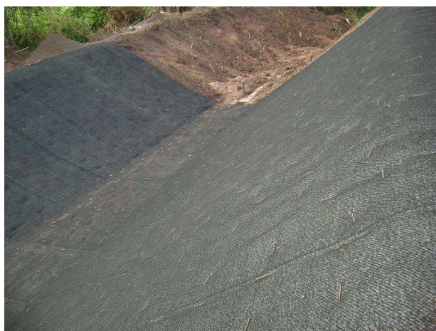
Figura 27: revestimiento de TRM
