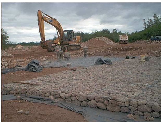
Figuras 21 y 22: ejemplos de colchonetas antes y después de su colocación.
