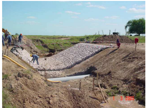
Figuras 1 a 4. Cañería descendida, Cañerías expuestas, Protección superficial después del descenso
