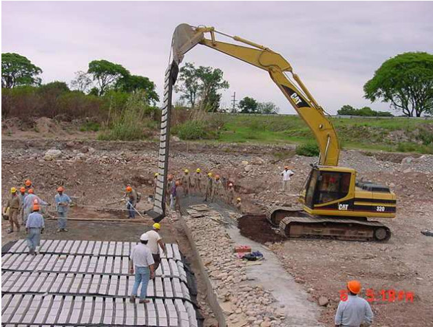
Figura 23: colocación de mantas
