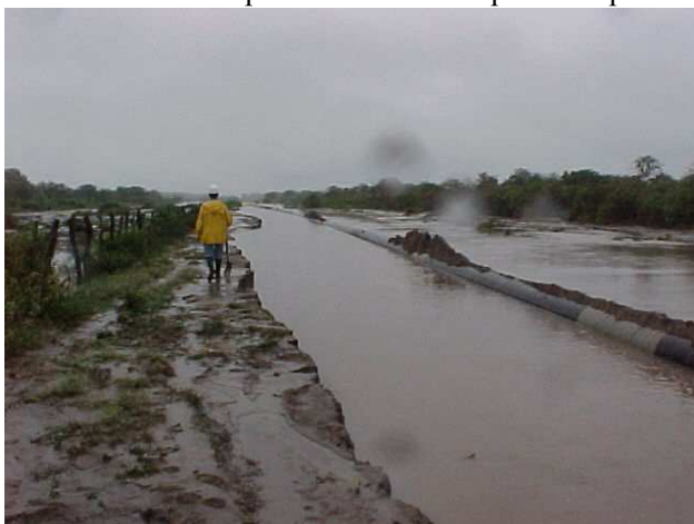
Figura 44: tubería flotando
