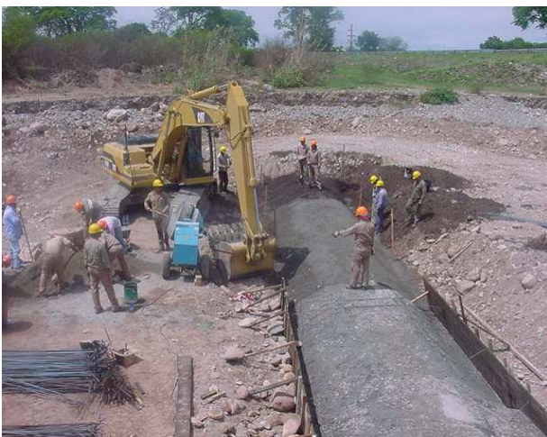
Figura 25: coraza de hormigón
