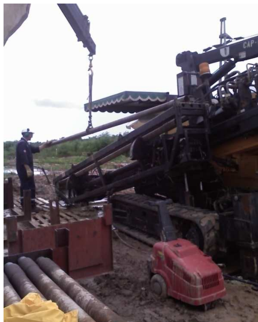
Figuras 5 y 6: Máquina perforadora y piletas de lodos bentoníticos
