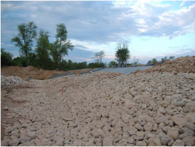
Figura 34: protección de margen
