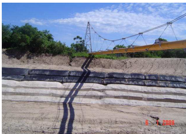
Figura 43: obra terminada con gunitado
