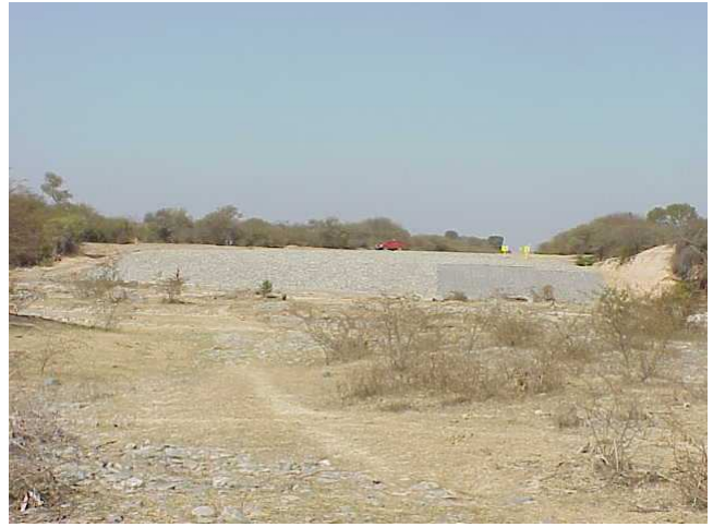
Figura 35: esquema terminado de rip-rap y colchonetas
