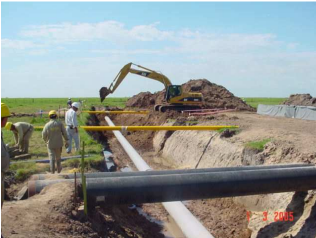
Figuras 1 a 4. Cañería descendida, Cañerías expuestas, Protección superficial después del descenso
