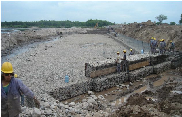
Figura 38: muro de gaviones y espigones de transición
