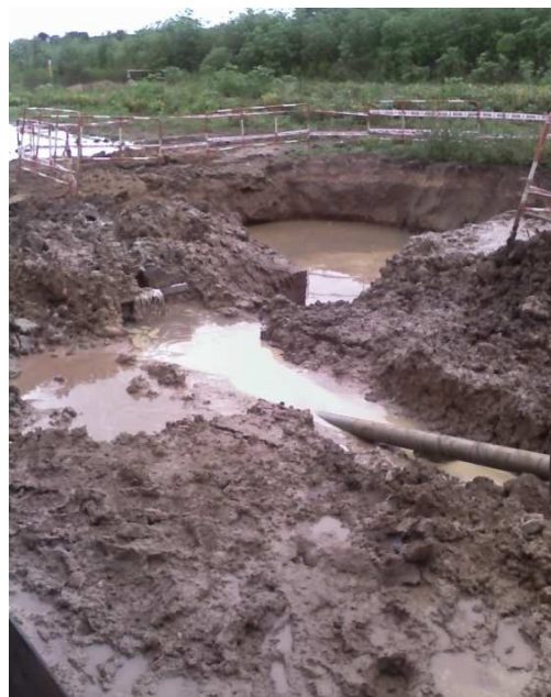
Figuras 5 y 6: Máquina perforadora y piletas de lodos bentoníticos
