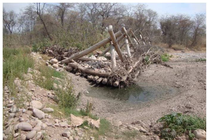
Figura 41: espigones tipo “parás de gallo”
