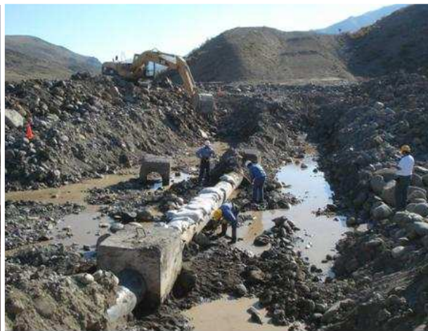
Figura 45: colocación de contrapesos
