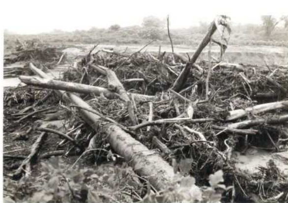
Figura 8: troncos y ramas sobre gasoducto
