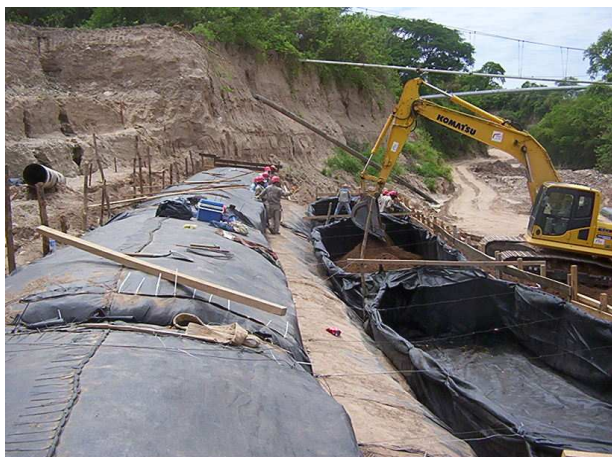
Figura 42: relleno y cierra de geotubos
