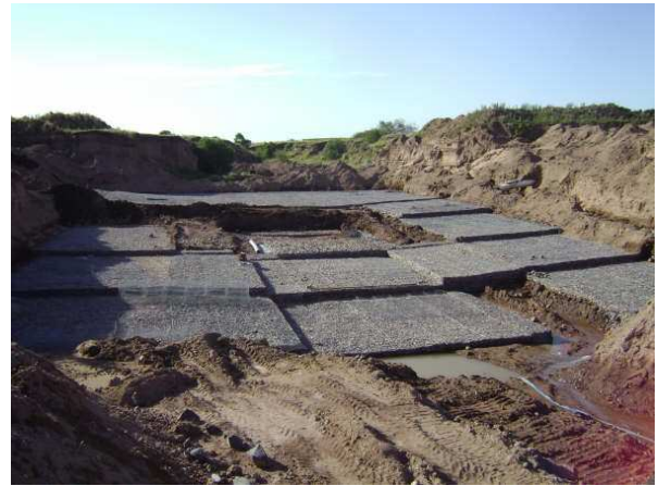
Figuras 12 a 15: ejemplos de cuencos disipadores
