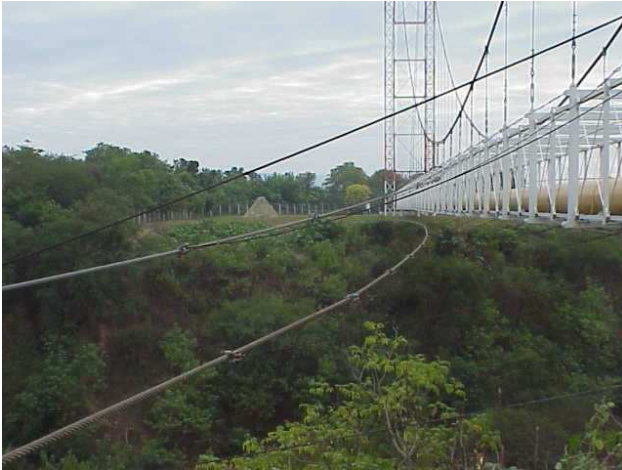
Figura 9: cruce aéreo de 200 m de luz
