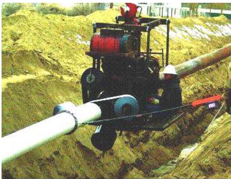
Figura N° 4- Aplicación de Cintas Laminado Plástico
