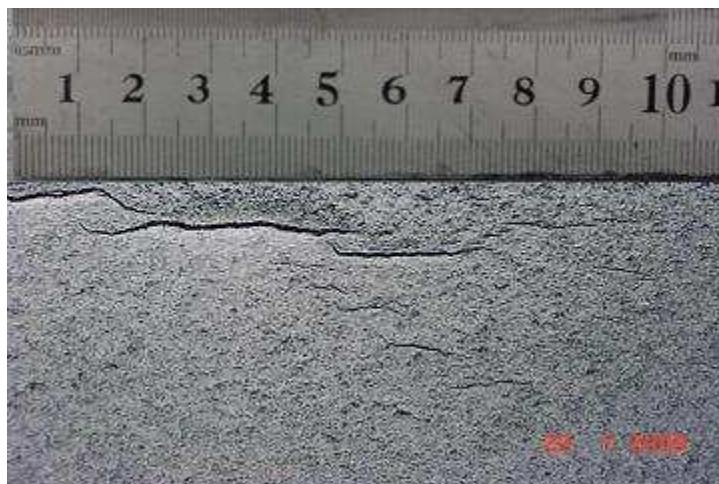
Figura N° 10 – Fisuras Originadas por SCC
