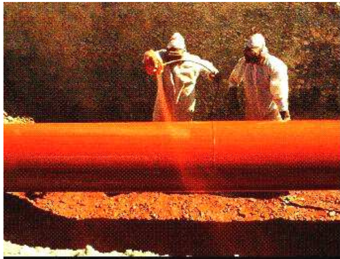
Figura N° 9 – Recobertura de Gasoductos en Operación
