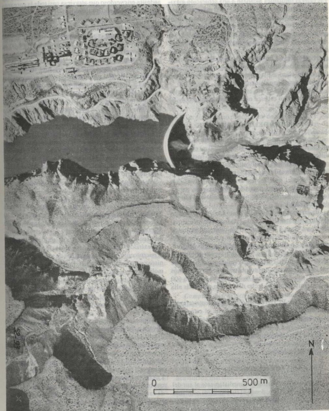
Figura 6: Vista aérea de la presa Agua del Toro.
