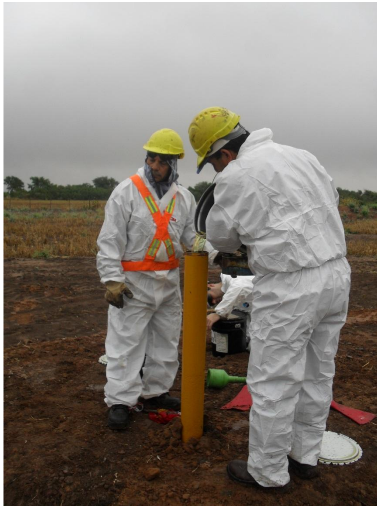
Foto 4 – Vertido del líquido inhibidor de corrosión y bactericida
