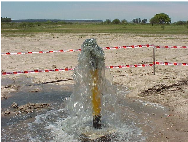
Fotos 1y 2 – Verificación de circulación de aire y eliminación del agua en el interior del caño camisa
