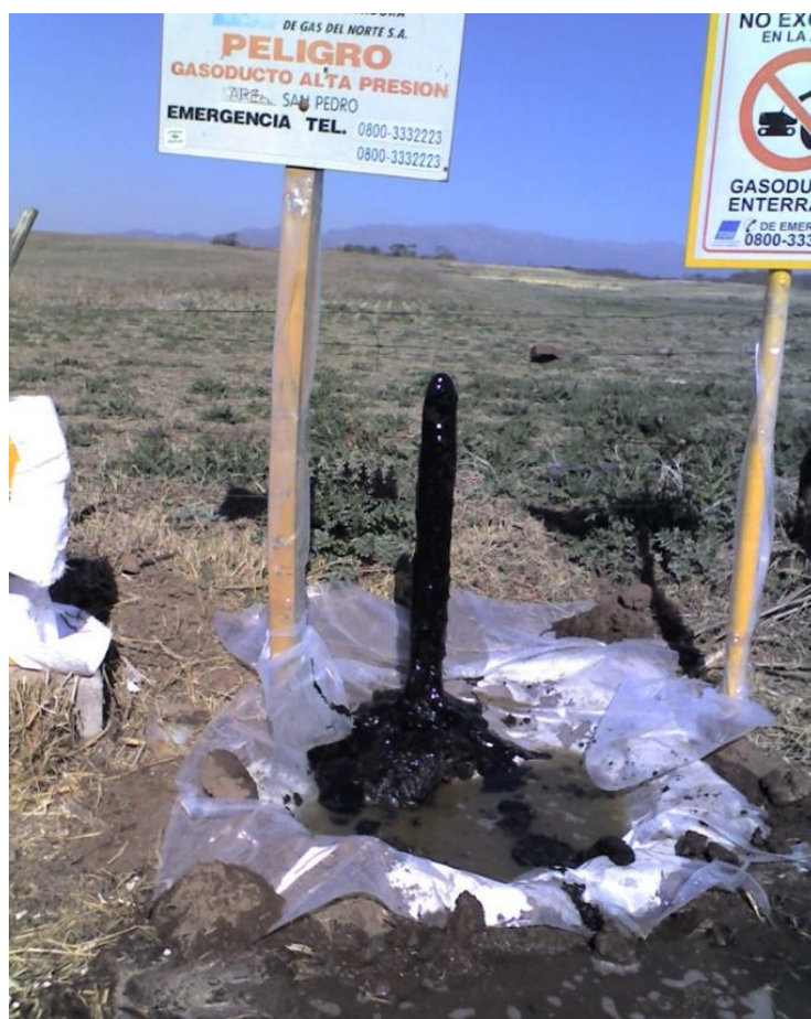
Foto 6 – Etapa final del llenado con cera microcristalina
