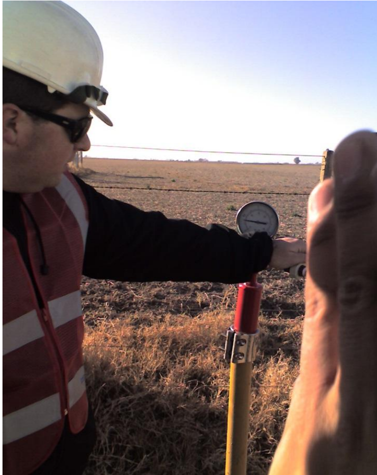
Foto 3 – Prueba de estanqueidad del caño camisa y venteos
