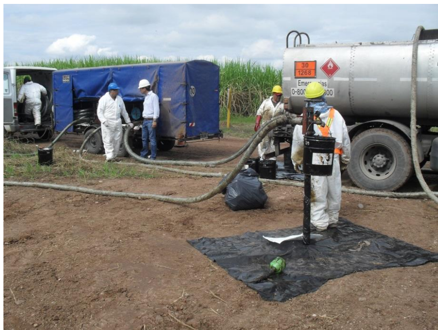
Foto 5 – Inyección de la cera microcristalina
