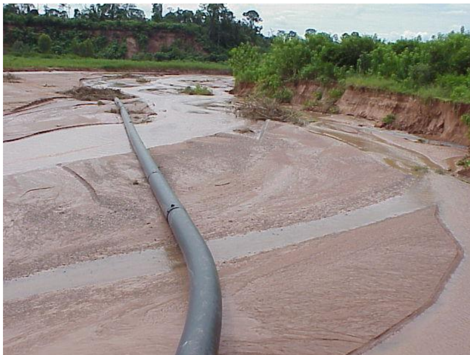
Figura 9. Cruce del Riacho Seco - Exposición del cuello de cisne en margen derecha o sur
