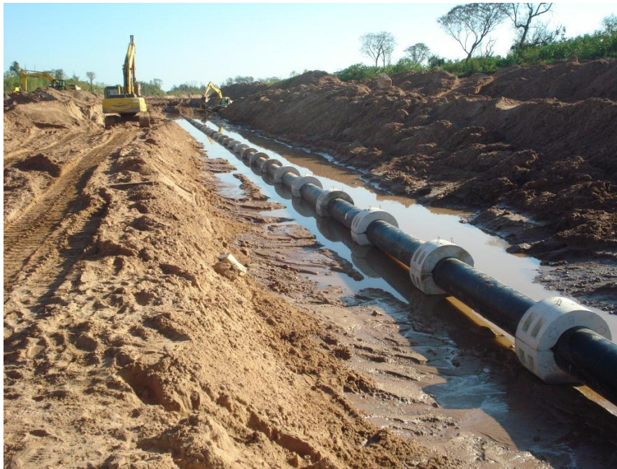
Figura 20. Operación de bajada y posterior contrapesado
