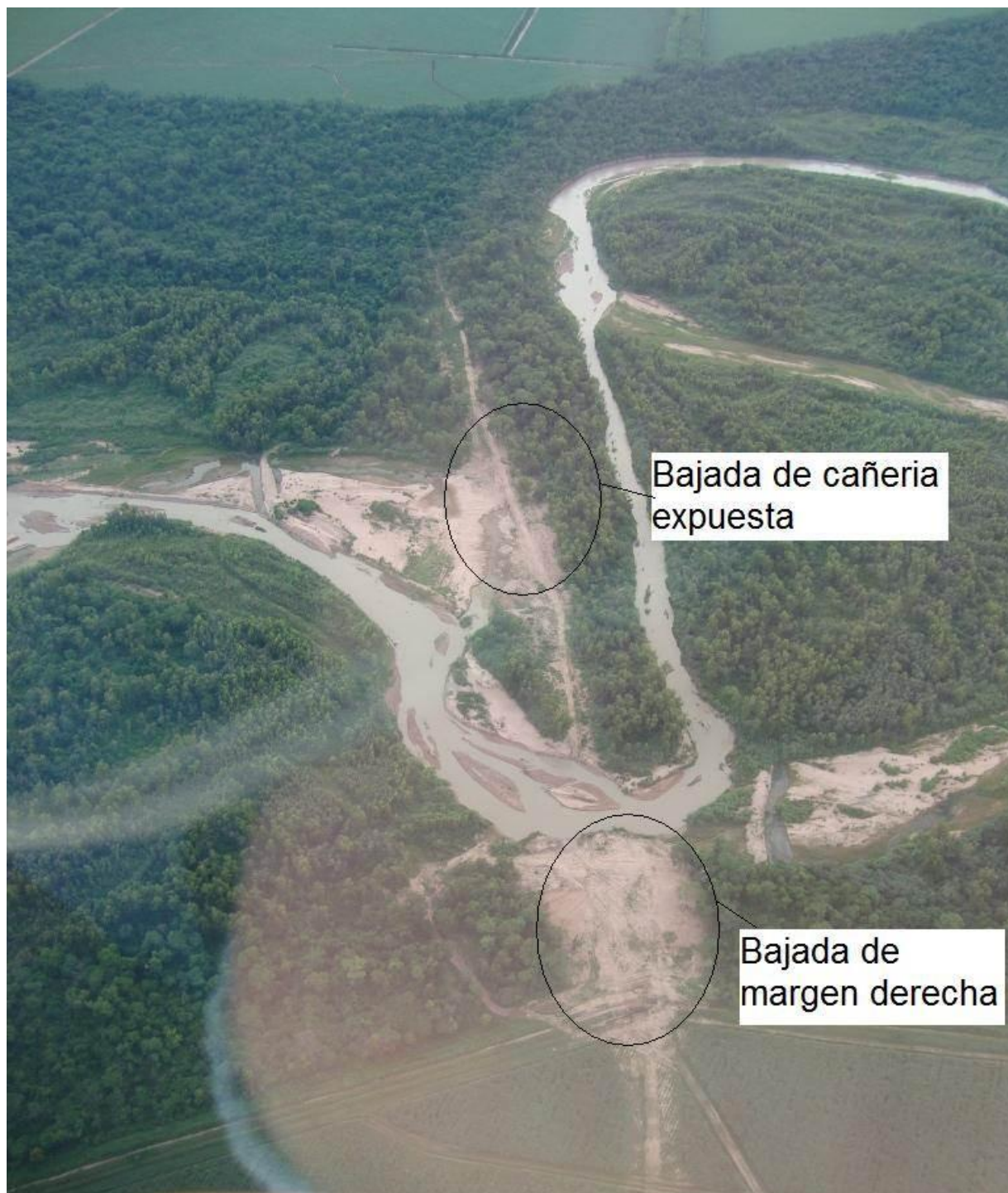
Figura 19. Situación del cruce luego de la bajada de cañería
