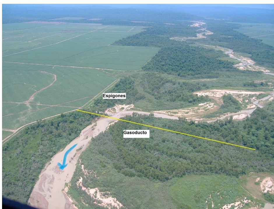
Figura 15. protección del cuello de cisne mediante espigones que reconstituyen la margen erosionada
