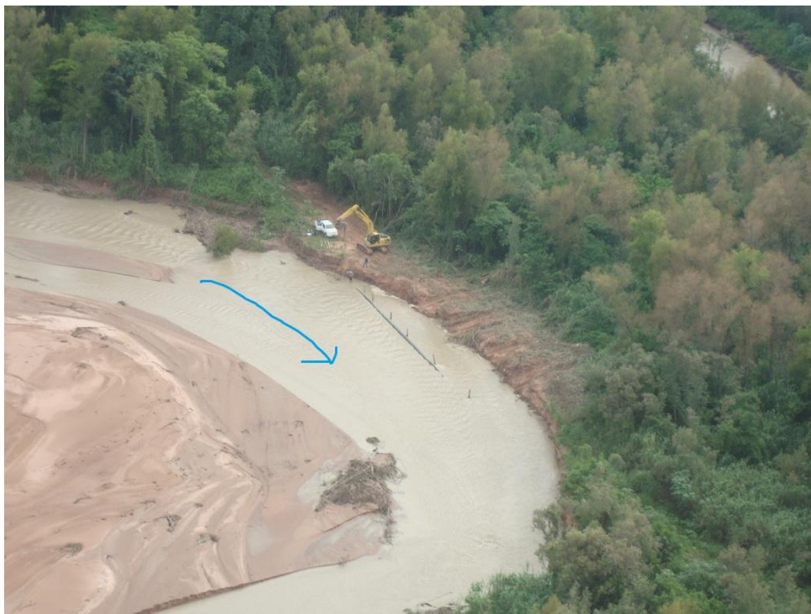
Figura 17. Destape del gasoducto aguas arriba del cruce
