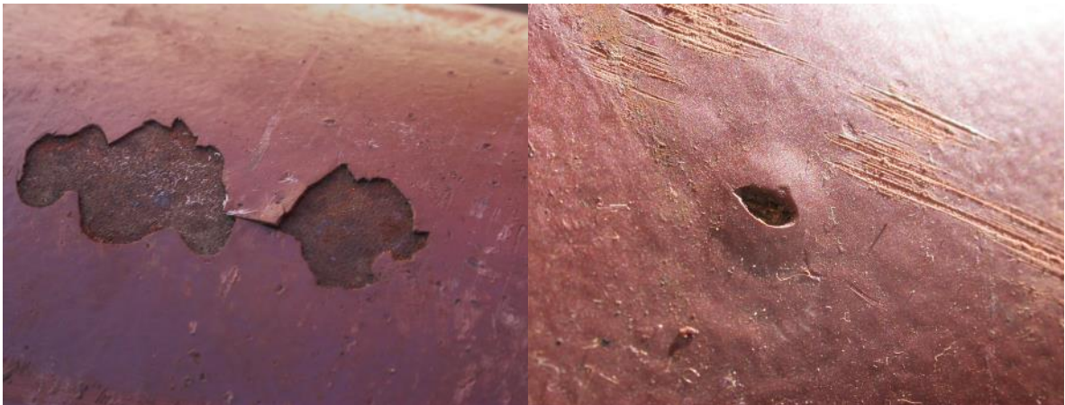
Fig. 4. Desprendimiento de coating, pit y raspones en el cuerpo de la muestra 1.
