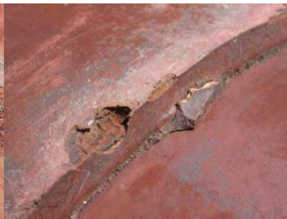
Fig. 10. Remanentes de resina epoxi del embonamiento en el borde de junta 2B.
