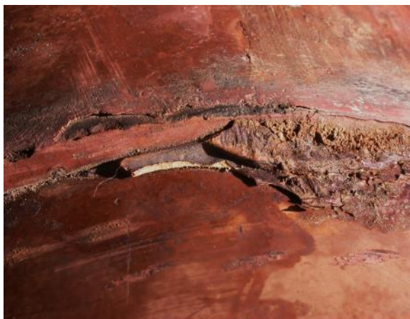
Fig. 10. Remanentes de resina epoxi del embonamiento en el borde de junta 2B.
