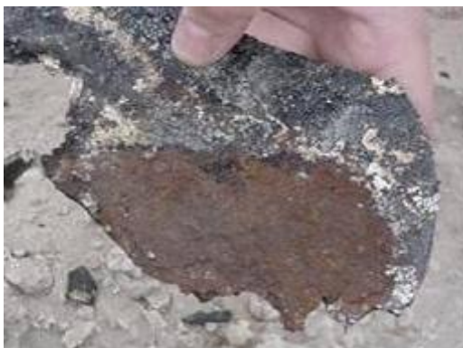
Fotografía 9. Vista de la interfase ducto/revestimiento.
