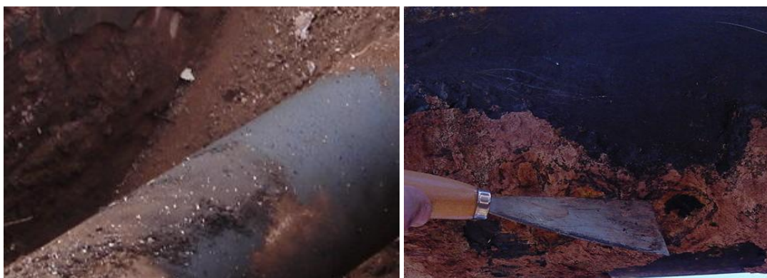
Fotografía 8. Vista de la zanja y de la cañería antes de la preparación superficial.
