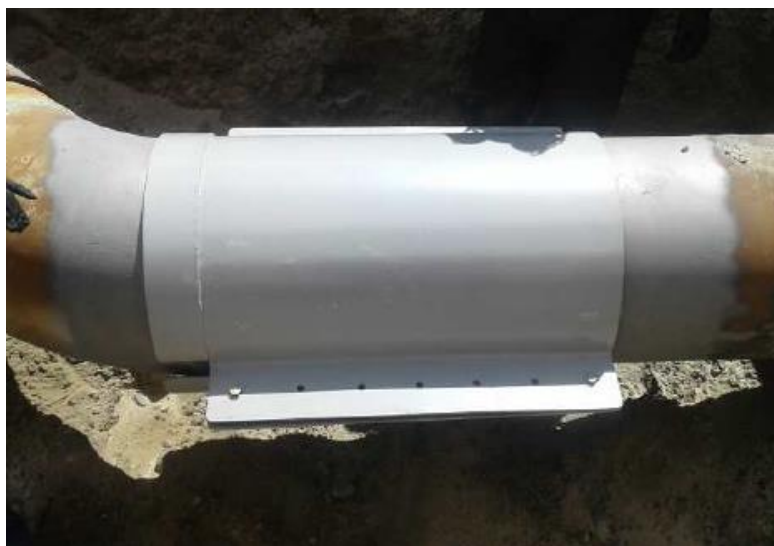
Figura 14.- Reparación provisoria en cañería de descarga.
