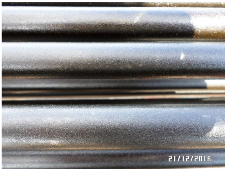
Figura 6. Estado de las VB de material KD en pozo 3.
