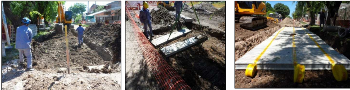
Figura 9.- Tareas de Instalación de Losetas
