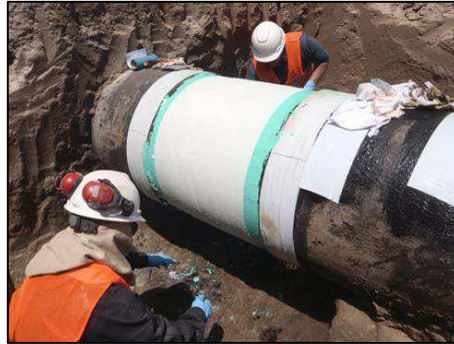
Figuras 13.- Acondicionamiento final en tareas de reparación
