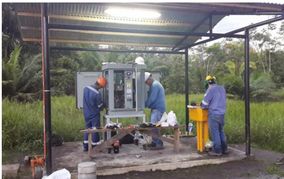
Figura 19: Personal trabajando en la instalación del equipo rectificador.
