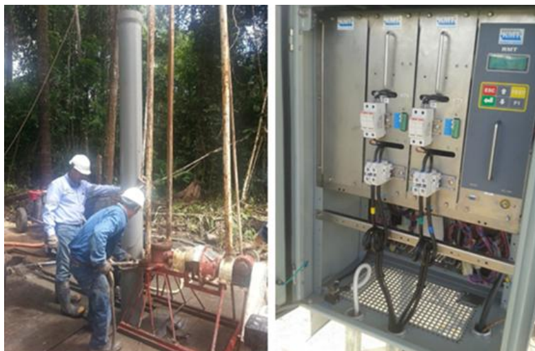
Figura 18: Instalación de casing de dispersor profundo (izquierda) y detalle de equipo rectificador automático (derecha)
