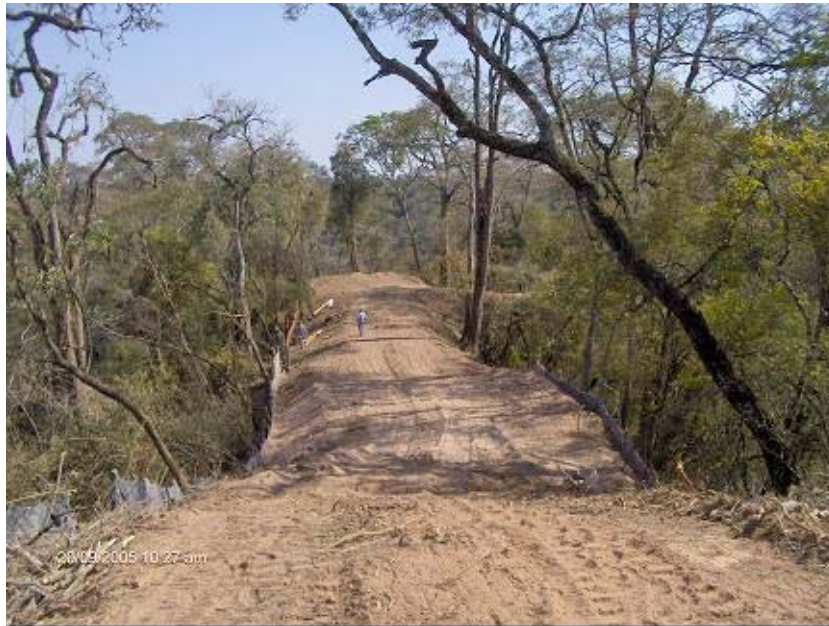
Figura 6: Construcción de trinchos durante la apertura de la pista.
