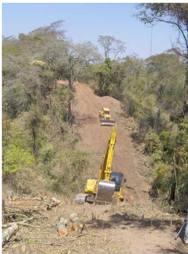
Figura 3: En primer plano retroexcavadora realizando tareas de destoconado y recuperación del suelo orgánico, más atrás topadora realizando el movimiento del subsuelo.
