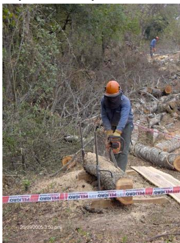
Figura 5: Tableado de madera para la construcción de trinchos
