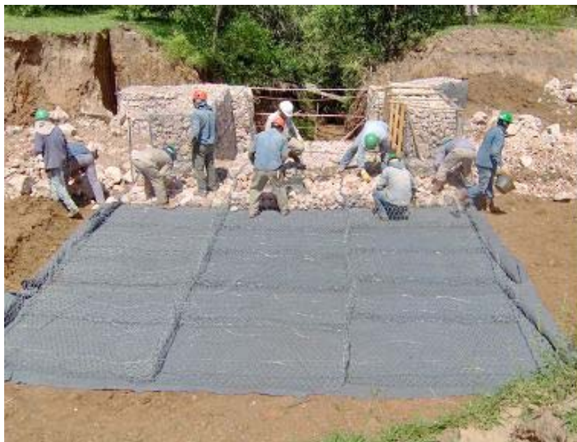
Figura 7: Tareas de ejecución de obras de control de erosión en Quebrada.
