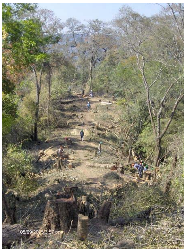
Figura 2: Tareas de Desbosque, durante la apertura de pista.
