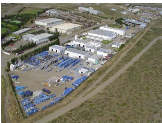
Ilustración 1. Estado inicial de la Planta
