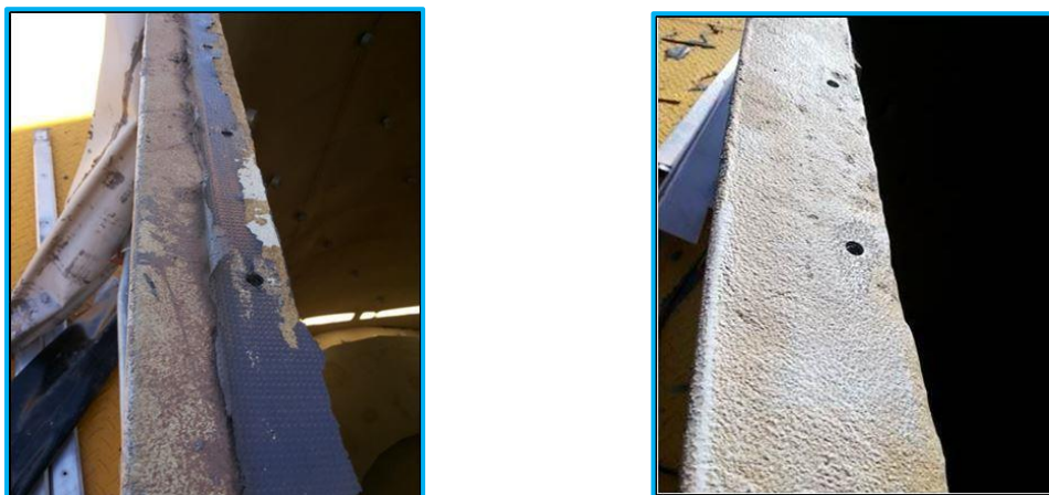
Fig. 18. Aspecto de la superficie del “ángulo cantonero” antes y después del tratamiento de “limpieza de prueba”
