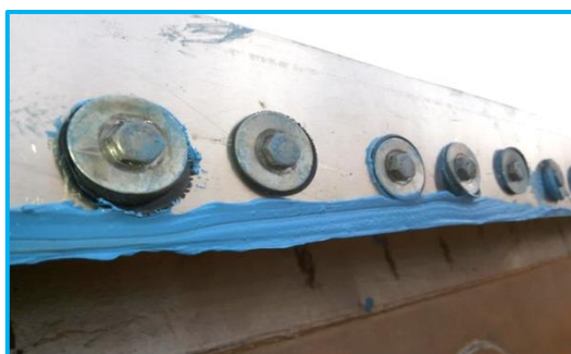
Fig. 21. Terminación del sellador sobre el “faldón”.
