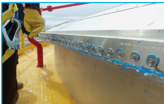
Fig. 26. Observación visual durante el transcurso de la prueba de estanqueidad para verificar la existencia de fugas.
