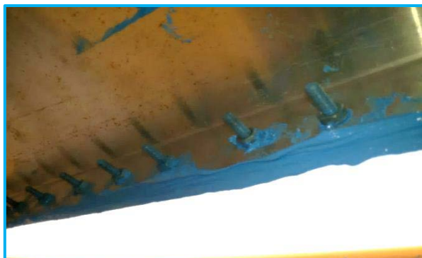
Fig. 22. Aplicación del sellador sobre el “contra-faldón”, luego del montaje.
