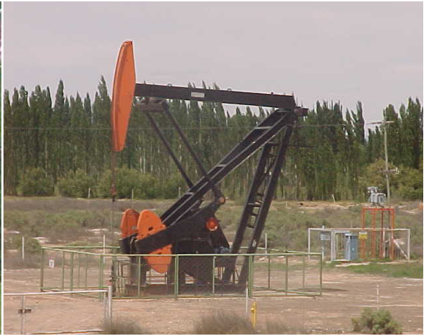
Figura 3: Bombeo mecánico pozo del Yacimiento.
