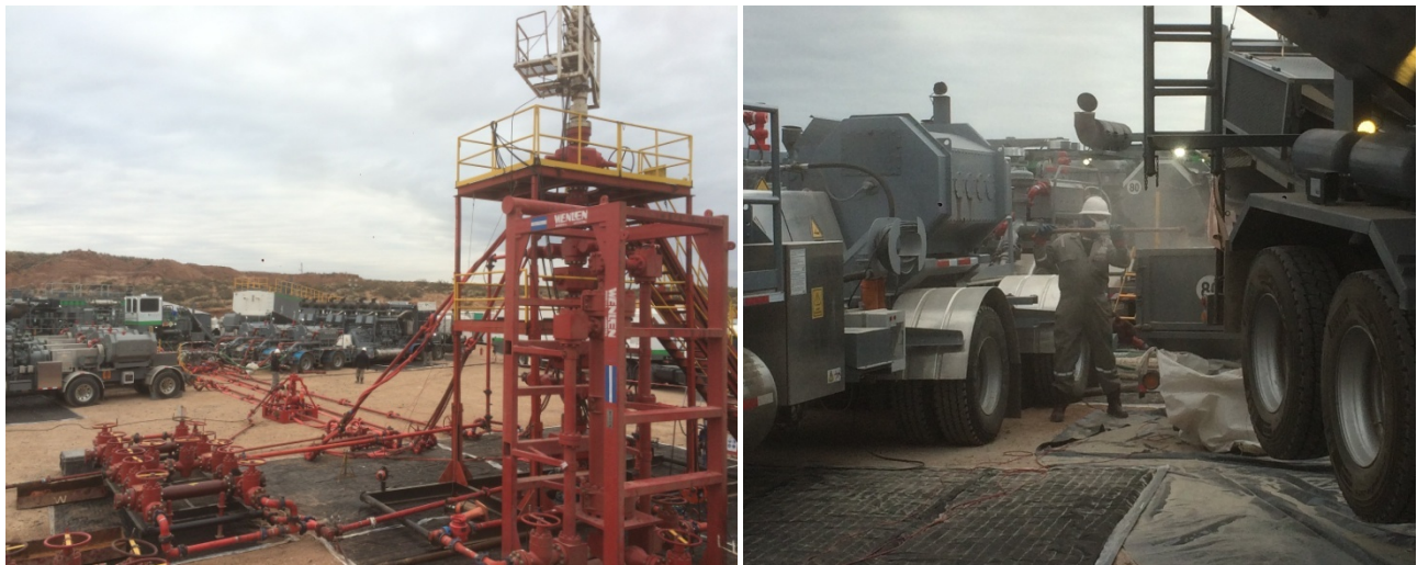
Figura 7: Operación bombeo squeeze sólido en el pack de fractura.
