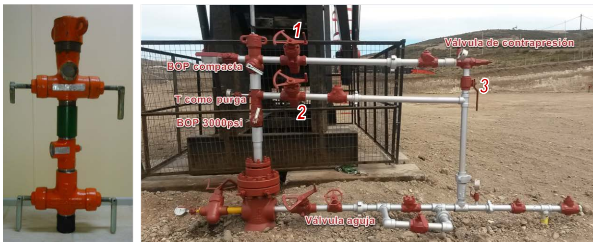
Figura 11 – Configuración armada con material disponible y puente armado en el pozo E-930(d)
