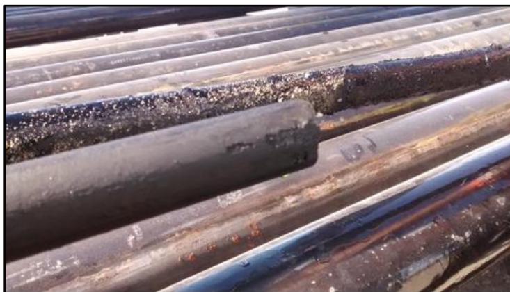
Ilustración 7: Zona de inicio de falla- Picado profundo
