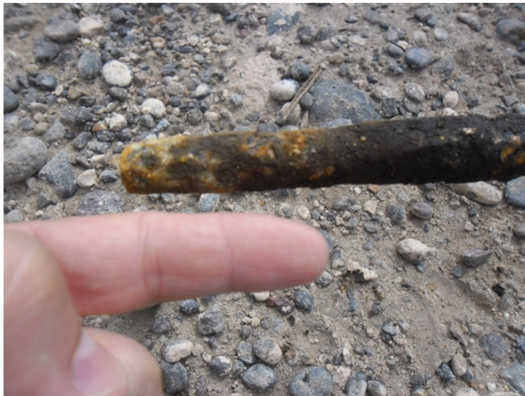
Figura 6; Caso testigo del grado de corrosión
