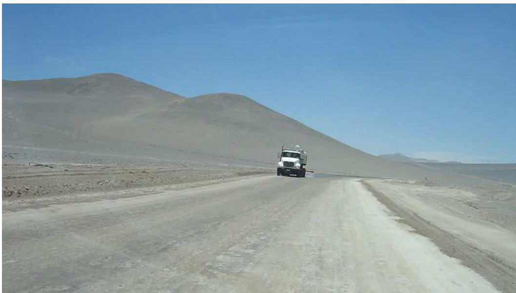
La ruta B-385 en el Desierto de Atacama es llamada la Ruta de la Sal, pues su carpeta de más de 170 km esta completamente estabilizada en base de este compuesto mineral.
