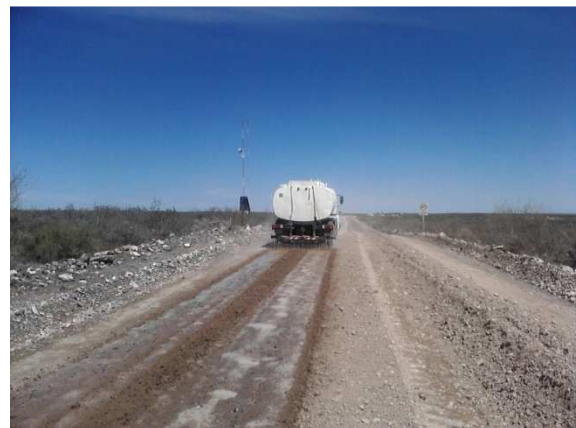
Riego con Solución Salina
