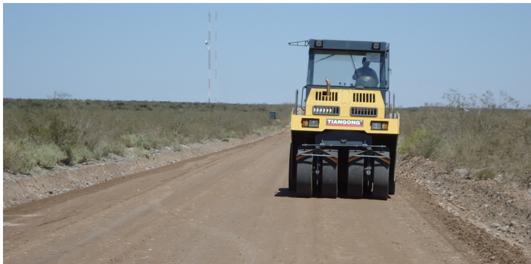
Compactado y Sellado de la Calzada
