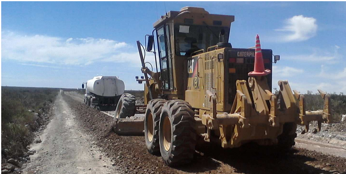
Mezclado con Motoniveladora
