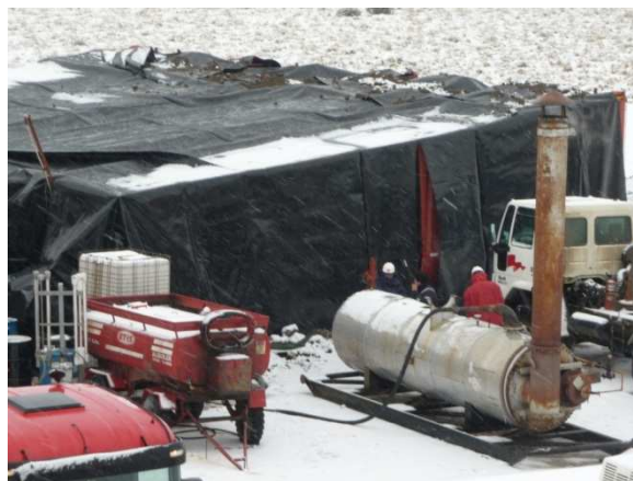
Figura 3: Las condiciones de trabajo fueron muy rigurosas. En algunas operaciones se debió incluso adicionar un calentador para mantener en estado líquido el gel en las piletas.
