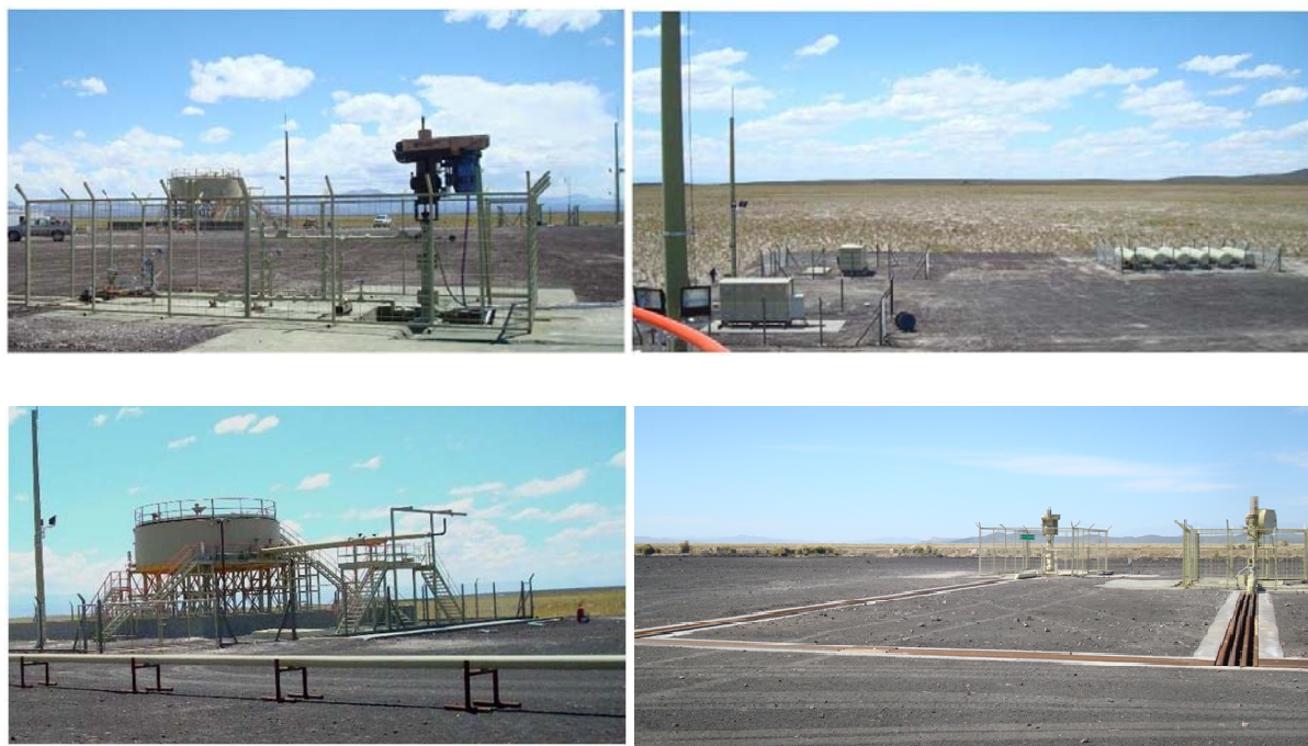
Figura 11 Instalaciones de Superficie
