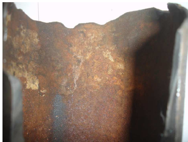
Figura 6: Zona erosionada del lado interno del tubing
