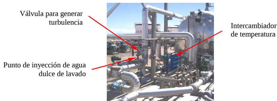
Figura 14 – Detalle Ingreso a Desalador
