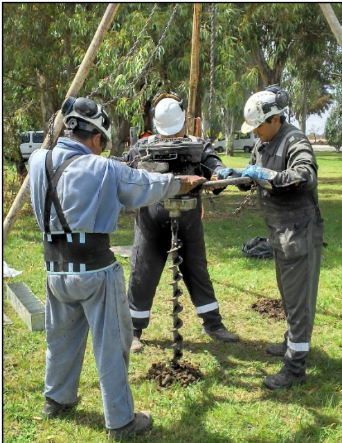
Figura 1. Perforación de sondeos
