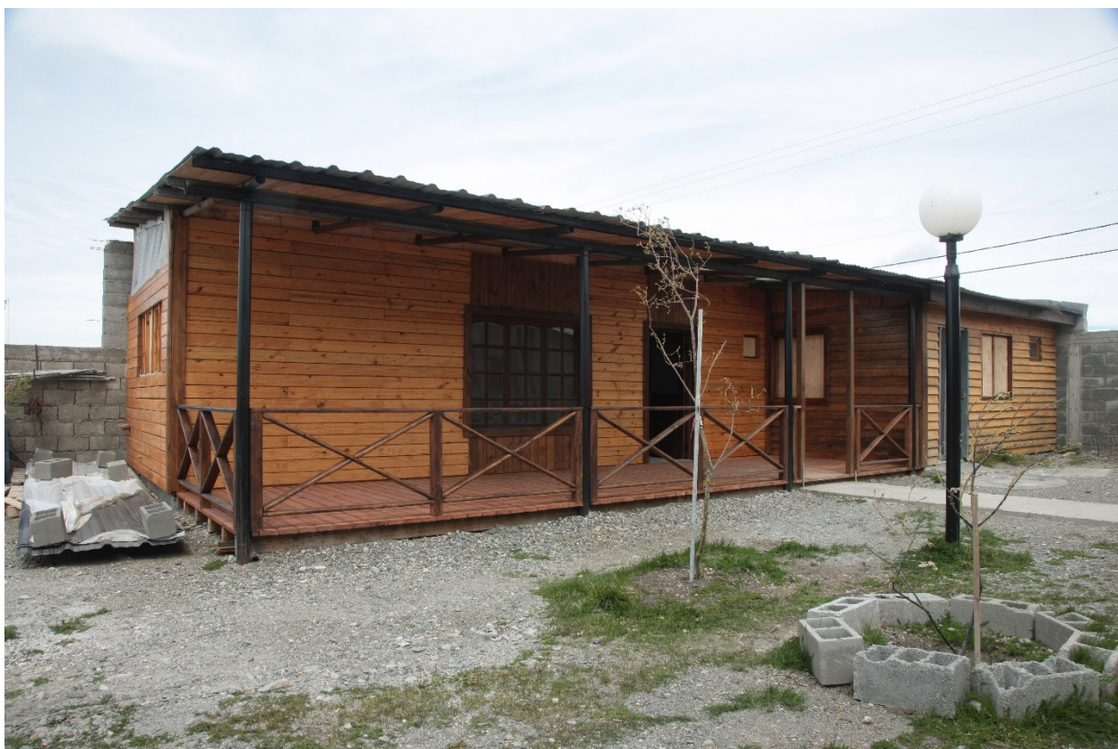
Vivienda de dos ambientes íntegramente construida con madera de packaging, Año 2018.
