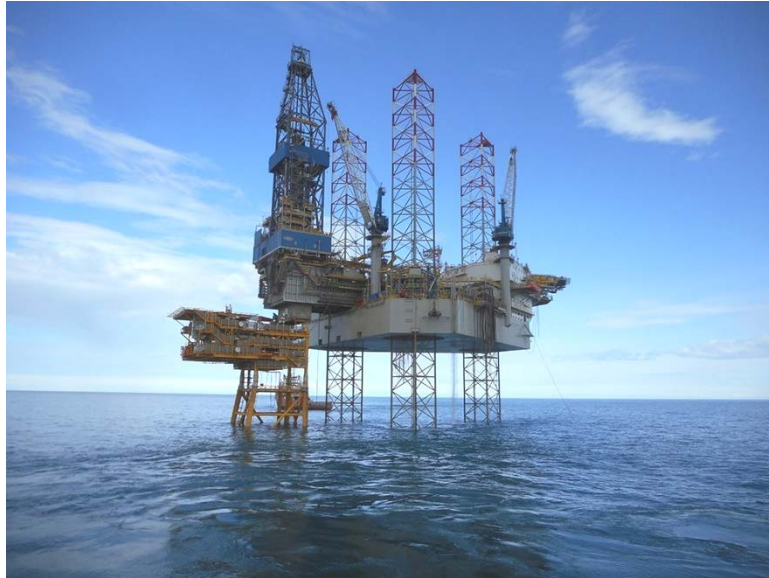
Plataforma de perforación instalada sobre el jaquet de Vega Pleyade
