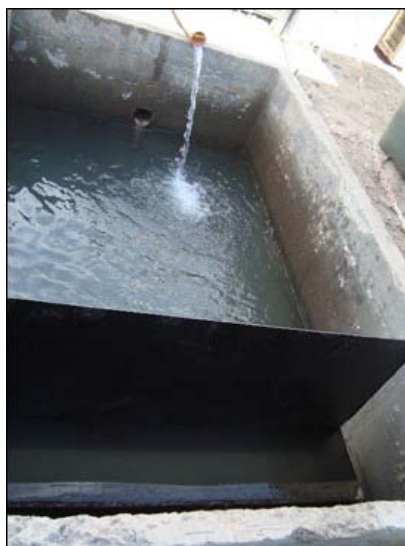
Ilustración 12 Tabique instalado. Llenado de PITEI con agua limpia
