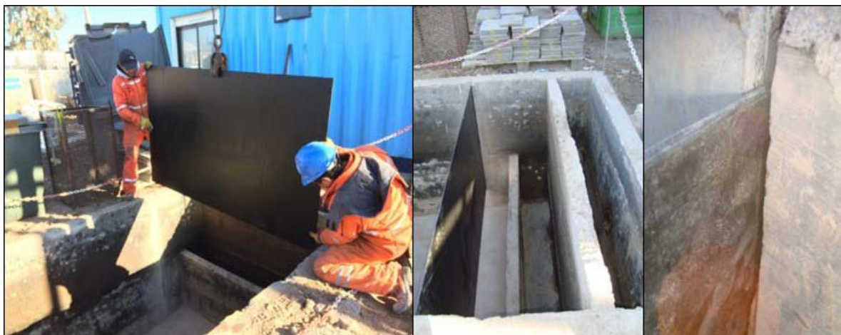
Ilustración 10 Instalación de tabique metálico en la PITEI
