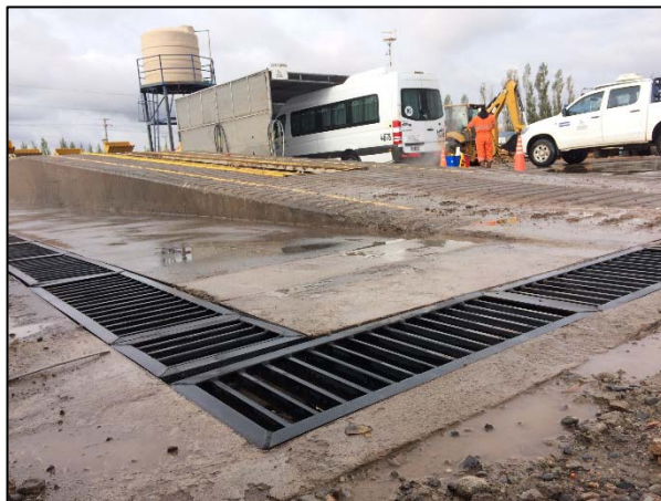
Ilustración 11 Ampliación de rejillas perimetrales al lavadero
