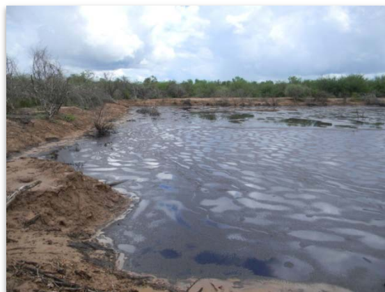
Fotografía 2: Sección inundada de la Pileta 2
