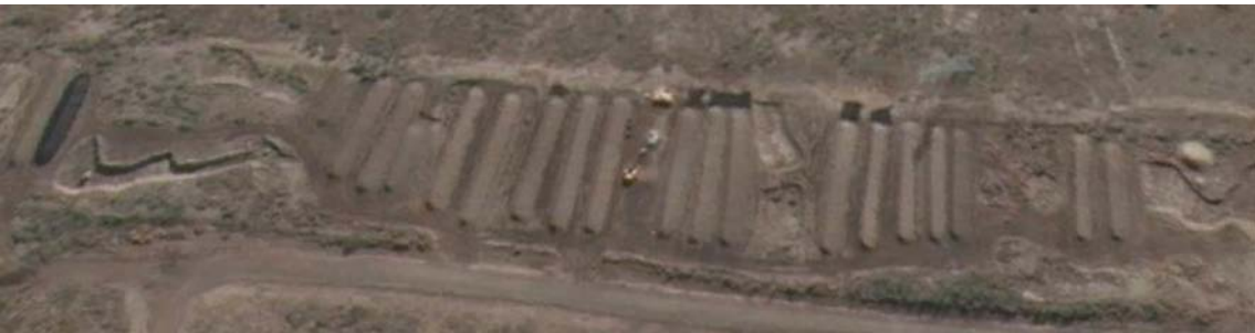
Fig. 1 Vista aérea de las Biopilas en la zona a remediar.
