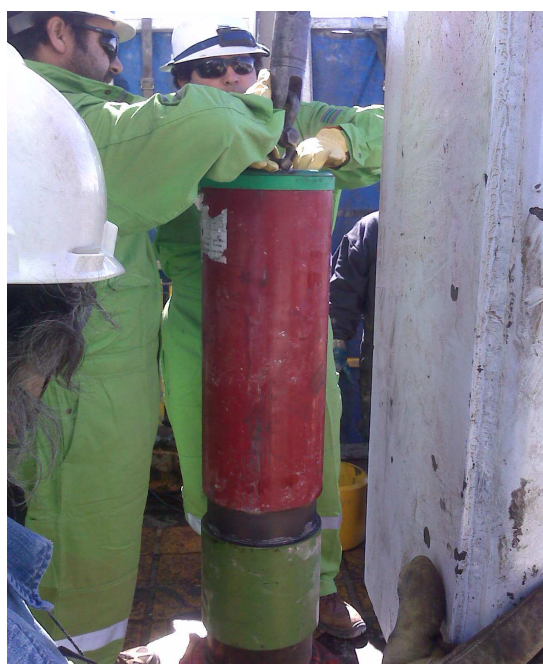
Fig#3 Instalacion de collar
