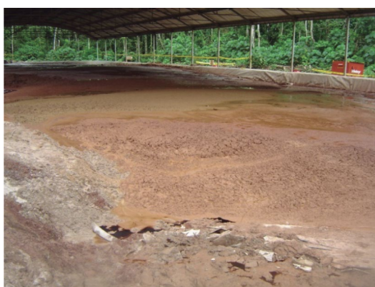
Foto 1. Vista de una pileta natural en la selva, colmatada de recortes de perforación, donde se aprecian las bermas de contención y una estructura metálica que sostiene la carpa impermeable del techo (Foto J. Albeiro)
