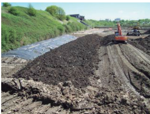
Foto 2. Vista de un área de Landfarming, en un área cubierta por geomembrana y que requiere de maquinaria pesada para airear los recorte de la perforación o suelos contaminados (Foto Internet).
