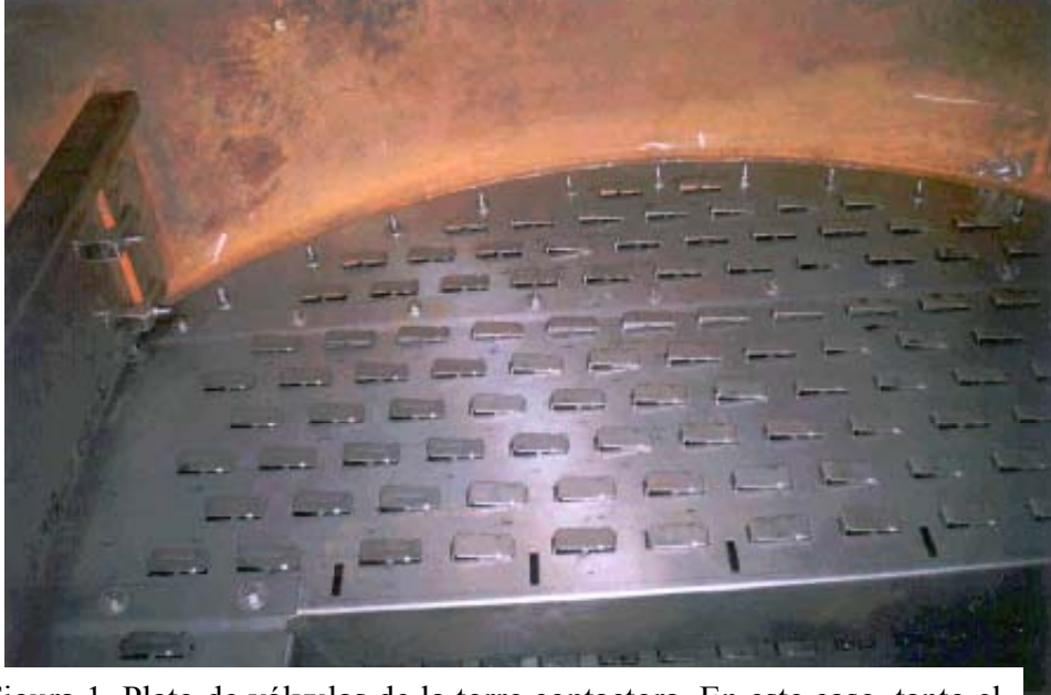
Figura 1. Plato de válvulas de la torre contactora. En este caso, tanto el plato como las válvulas son de acero inoxidable.
