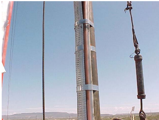
Figura 4: Sunchado del cable de potencia y tubos capilares
