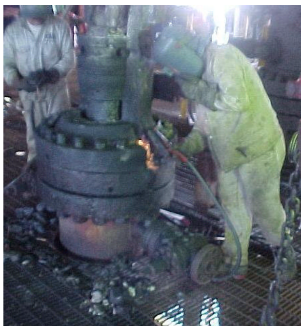
Fig. 7 – Realizando corte a cabezal de 20 ¾ x 13 5/8 5M
