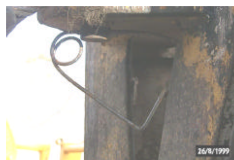
Anclajes deficientes.
