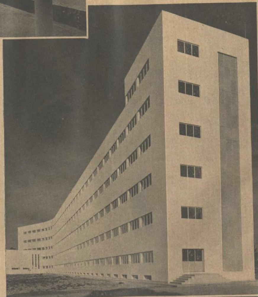
Vista posterior del edificio.
