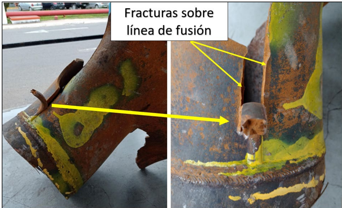
Imagen 9 – Codo inferior – Se observó que la soldadura longitudinal fracturó sobre la línea de fusión / ZAC.
