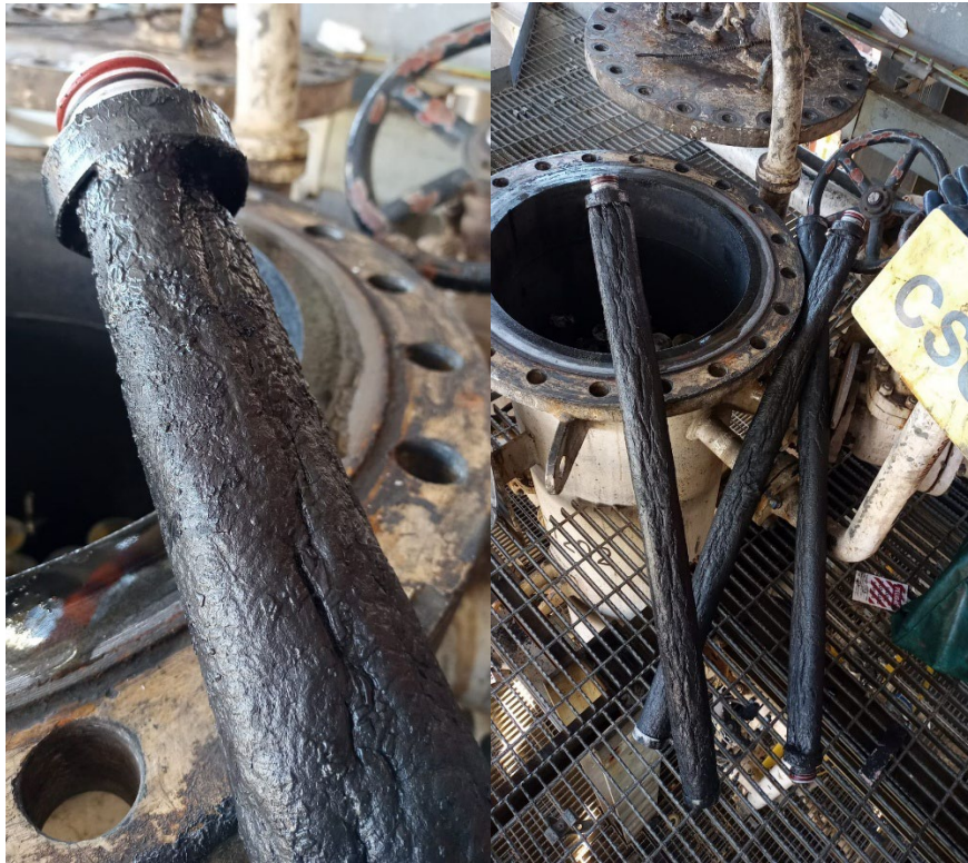
Figura 2: Cartuchos sucios de los filtros de amina
