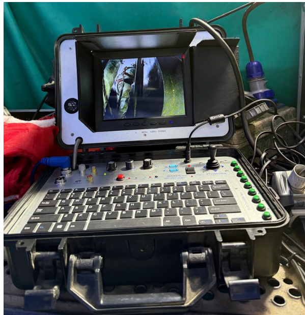
Figura 11 - Pantalla para seguimiento de trabajos en el interior del equipo.
