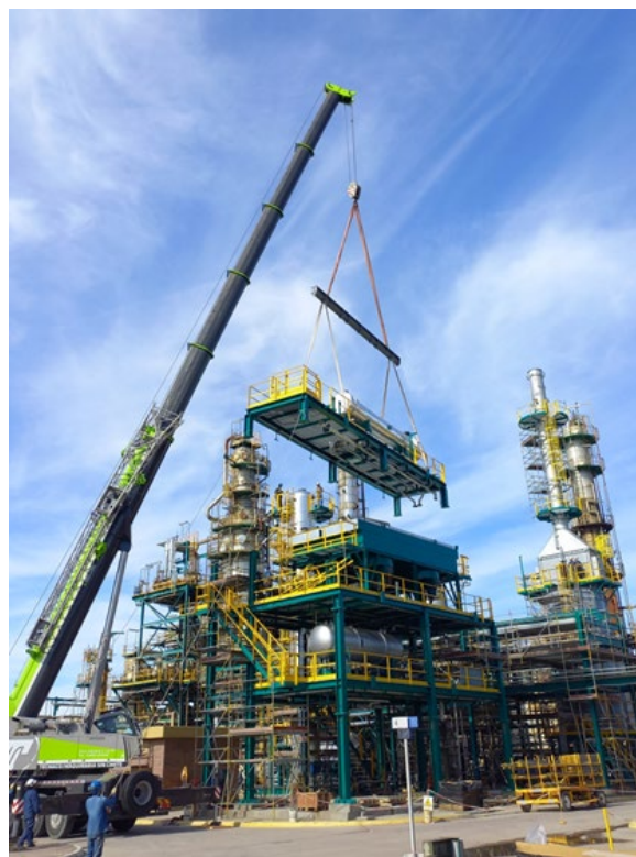
Imagen N°11 Montaje Nivel E1190 del SK-103
