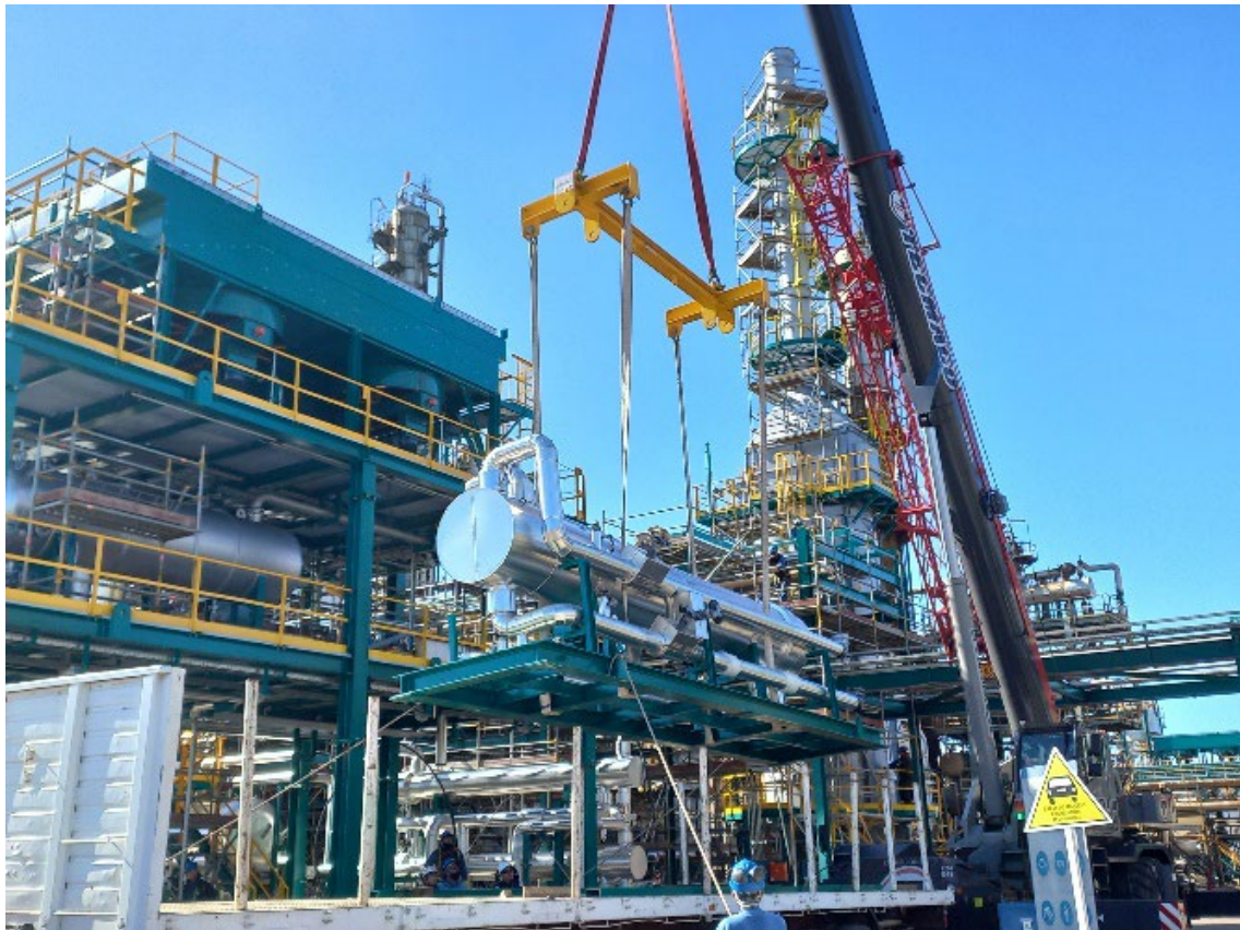
Imagen N°12 Montaje intercambiador Crudo- Fondo de Vacío
