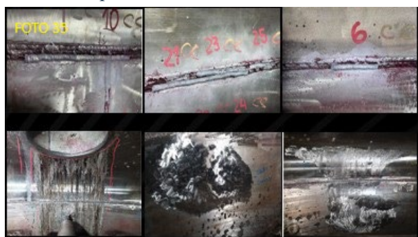
Reparación de Casquete y Envoltente
