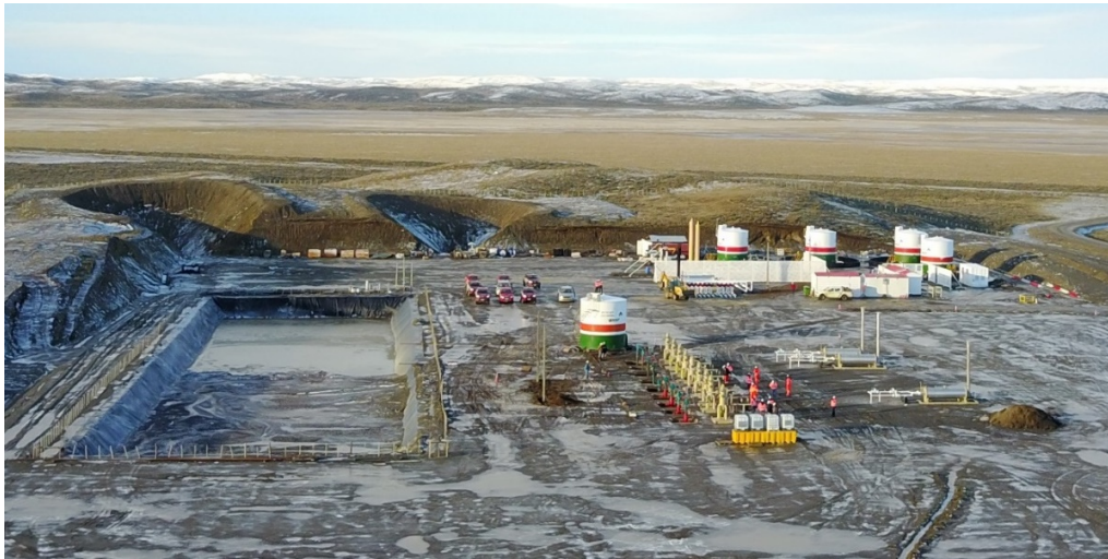
Fig. 8 – Fotografía de un Pad Tradicional, donde se observa en la zona de pozos y en la zona posterior la de procesamiento de gas.
