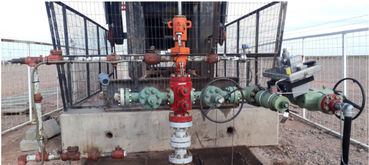
Fig. 16: Instalación del conjunto de despresurización en Pzo-5.
