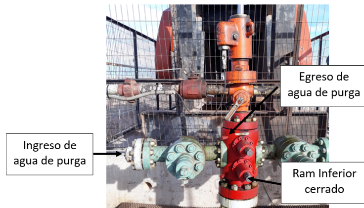
Fig. 19: Prueba Hidráulica en instalación de Rod Lock - BOP
