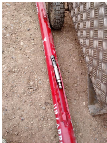
Fig. 7 – Niple 2 7/8” y válvula de inyección de producto químico.
