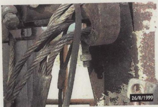
Anclajes deficientes.
